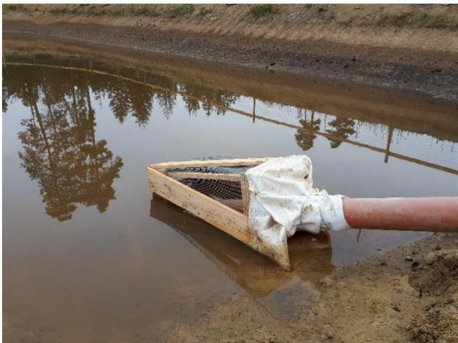
Abbildung 9: Beispiel einer Sicherung, um im Zuge einer Entwässerung Individuenverluste von Amphibien zu vermeiden.
