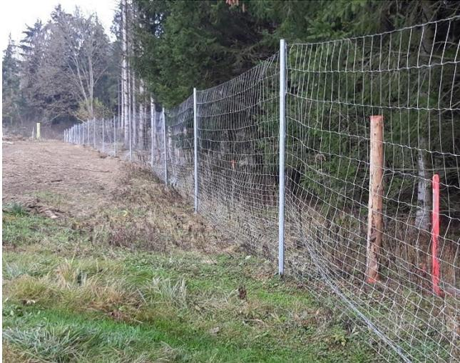
Abbildung 7: Beispiel einer Wild-sicheren Abzäunung entlang eines Betriebsweges
